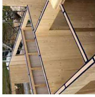
SonusStripe Entkopplungsstreifen wurden für den Einsatz auf der Baustelle entwickelt. Die Längskanten sind mit dem speziellen SonusTape versiegelt. Dies stellt im eingebauten Zustand die Wasserempfindlichkeit her, erhöht die Schlagfestigkeit der Kanten und macht die Stoßfuge luftdicht. Der Längszuschnitt kann mit einem Messer oder einer Stichsäge erfolgen. Die offene Schnittkante wird dann wieder mit dem SonusTape (Zubehör) verschlossen.
