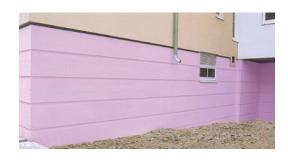
Druckfeste Wärmedämmplatte aus extrudiertem Polystyrolhartschaum mit **geprägter Oberfläche.**
