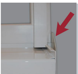
Bild 2 Abdeckung des Gewerkelochs mit dem bewa-plast Entwässerungsmodul.
