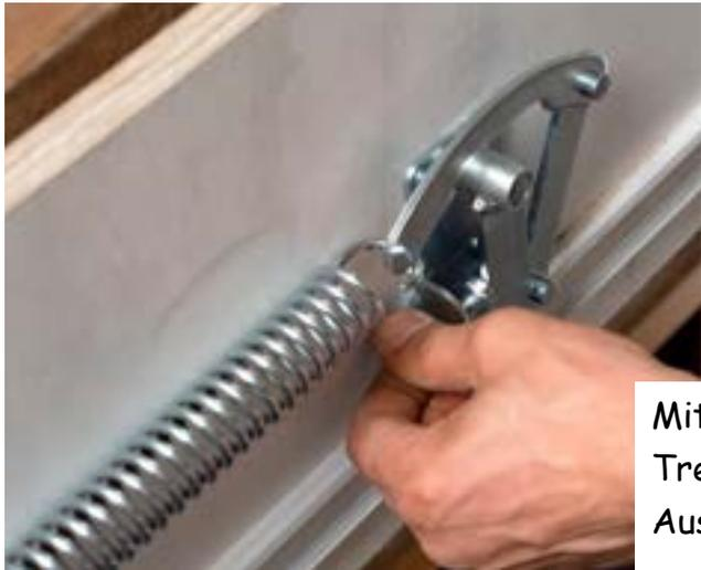
Mit der Stellschraube am Knickhebel die Ausladung der Treppe noch einmal korrigieren, so dass das Leiternteil beim Aus- und Einklappen nicht an den Lukenkasten schlägt.
