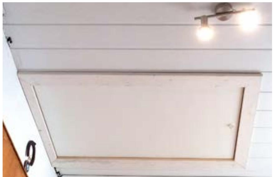
Die beiliegenden Abdeckleisten aus Kunststoff wurden aufgrund der Vertäfelung und auf Wunsch des Bauherren angefertigt. Kiefernholz ist gut geeignet. Beim späteren Lakieren scheint die Maserung nicht mehr durch. Alle Leisten werden auf den Lukenkasten genagelt. Lack in RAL 9016 passt gut.
