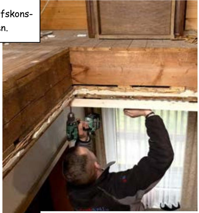
Alternativ Leisten mit einer Teleskopstange/Baustütze feststellen.
