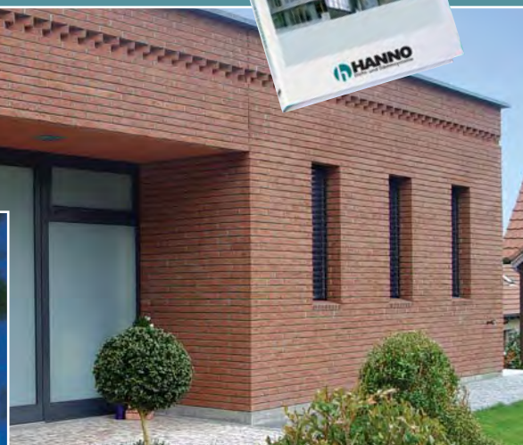
Objekt mit Fenster- und Fassadenfugen im Sichtmauerwerk
