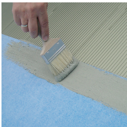
Zum wasserdichten Verkleben der Stöße PCI Pecilastic Roll&Go fehlstellenfrei auf die PCI PecilasticW Bahn aufbringen.
