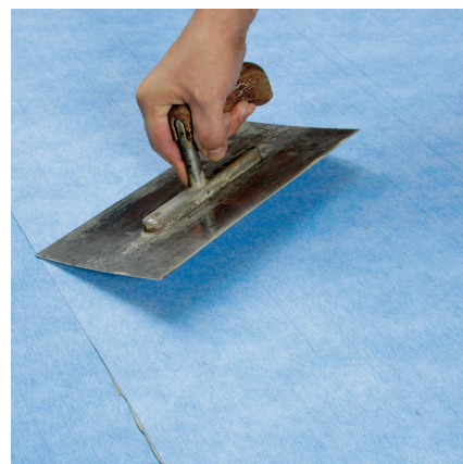
Abdichtungsbahn mit Traufel, Gummiwalze oder Klopfbrett andrücken.
