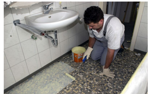
PCI Gisogrund Xtra Grip auf glatten gereinigten keramischen Fliesen und Platten.
