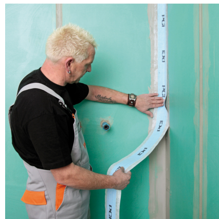
Anschließend wird das Spezial-Dichtband PCI Pecitape 120 mit der Hand ausgerichtet und leicht angedrückt...
