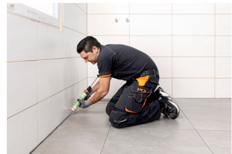
Elastisches Schließen von Boden-Wand-Fugen mit PCI Nanosil.
