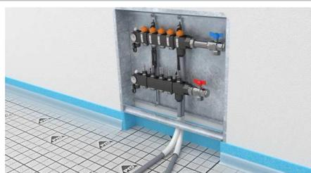
Der PYD®-AD20 Adapter wird am Gewinde des Rücklaufs angesetzt und die Überwurfmutter mit einem Ringmaulschlüssel vorsichtig angezogen.
