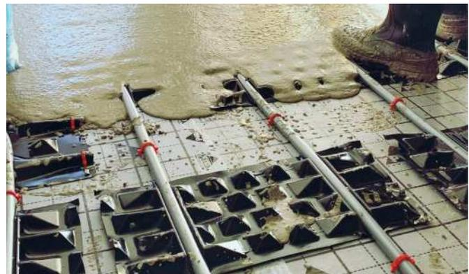
**Zu 7)** Wenn die Systemplatte als Trittschalldämmung ausgeführt wird, ist es zwingend erforderlich, dass diese durchgehend verlegt wird. Eine Unterbrechung der Trittschalldämmung oder gar das durchstoßen mittels Rohrleitungen hat einen negativen Effekt auf die Trittschalleigenschaften. Ein optimaler Trittschall kann somit nicht mehr garantiert werden.
