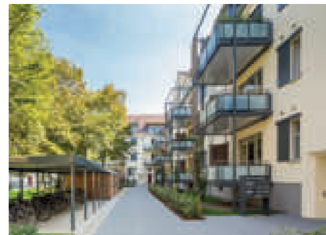
Mülltonnen und Carports sollten in sicherem Abstand zur Fassade positioniert werden.
