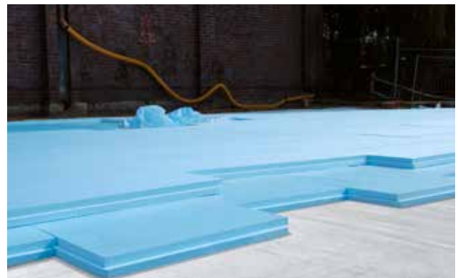
Abb. 18: Zweilagige Verlegung der Dämmplatten auf Sauberkeitsschicht in Beton
