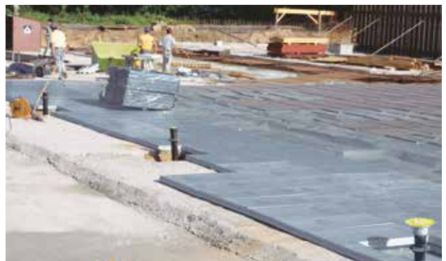
Abb.12: Dämmplatten auf der Beton-Sauberkeitsschicht verlegt
