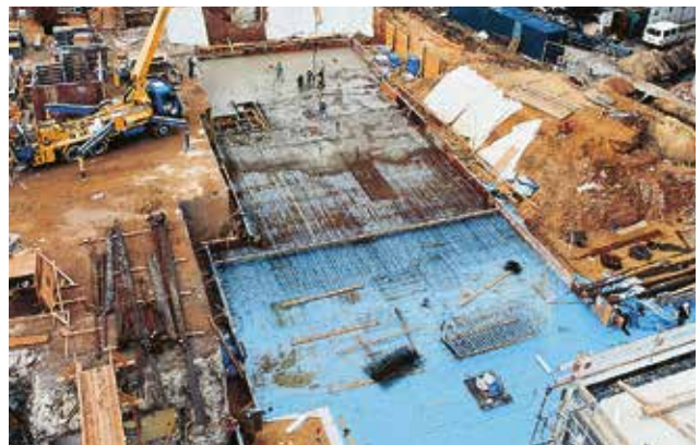
Abb. 31: Die blauen XPS-Dämmplatten sind auch während der Bauphase schon belastbar
