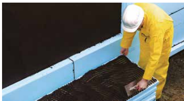
Abb. 32: Vollflächige Verklebung der blauen XPS Dämmung
