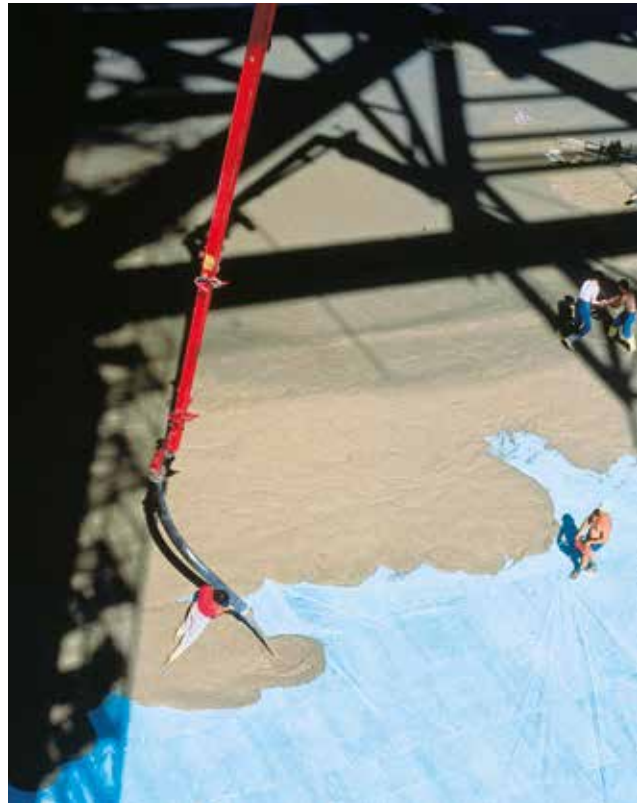
Abb. 41: Die Bodenplatte wird auf den blauen XPS-Platten, abgedeckt mit PE-Folie, betoniert
