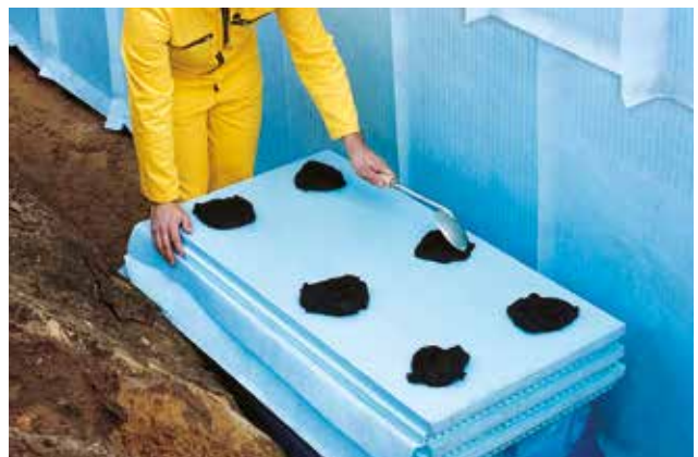
Abb. 28: Punktweise Verklebung der Perimeterdämmung
