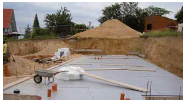
Abb. 19: Verlegung XPS-Dämmplatten unter lastabtragender Bodenplatte
