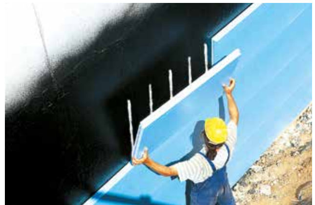
Abb. 25: Verlegung der XPS Dämmung auf der abgedichteten Kellerwand
