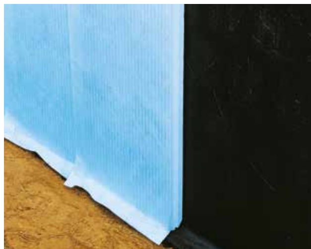
Abb. 37: Am Fußpunkt stehen die XPS Platten auf dem Fundamentvorsprung
