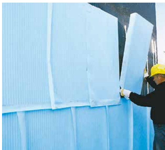
Abb. 34: Verlegung der blauen XPS Dämm-/Dränelemente
