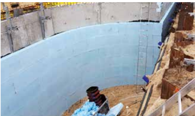
Abb.11: Dämmplatten auf der Kelleraußenwand verklebt
