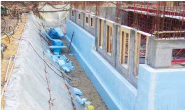
Abb.07: Dämmplatten zweilagig auf der Kelleraußenwand verklebt
