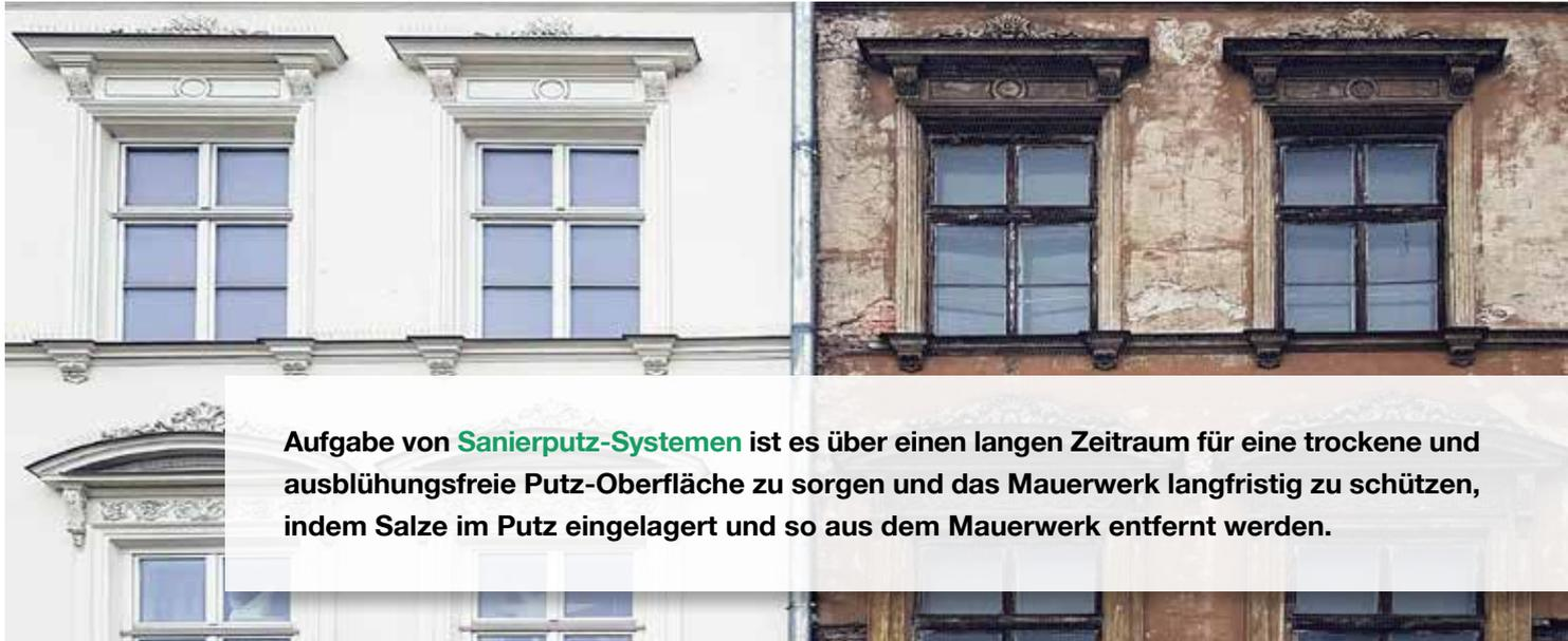
**Aufgabe von Sanierputz-Systemen** ist es über einen langen Zeitraum für eine trockene und ausblühungsfreie Putz-Oberfläche zu sorgen und das Mauerwerk langfristig zu schützen, indem Salze im Putz eingelagert und so aus dem Mauerwerk entfernt werden.
