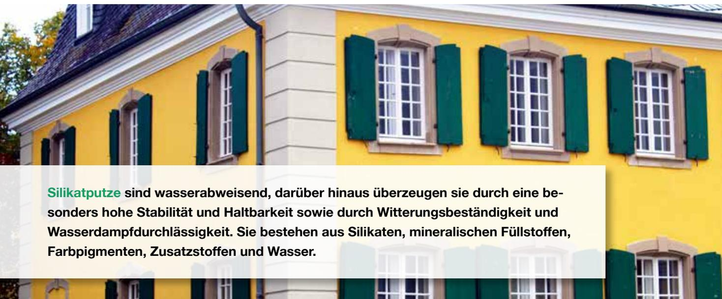
**Silikatputze** sind wasserabweisend, darüber hinaus überzeugen sie durch eine besonders hohe Stabilität und Haltbarkeit sowie durch Witterungsbeständigkeit und Wasserdampfdurchlässigkeit. Sie bestehen aus Silikaten, mineralischen Füllstoffen, Farbpigmenten, Zusatzstoffen und Wasser.
