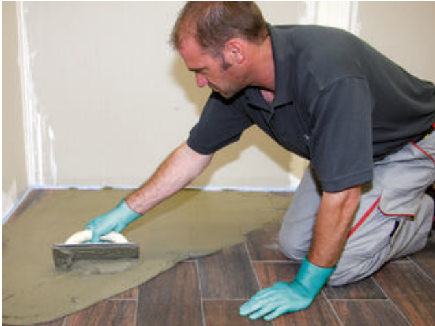
17) Verfugen der Fläche mit z. B. Sopro DF 10® DesignFuge Flex.
