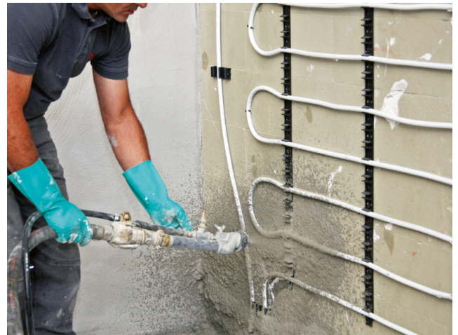
Sopro RAP 2® kann auch maschinell im Spritzverfahren aufgebracht werden – wie hier zur Einbettung einer Wandheizung (Kermi x-net c21).
