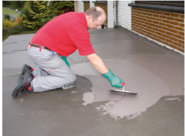
14) Aufbringen der 2. Schicht auf die schon nach 2 Stunden durchgetrocknete 1. Abdichtungsschicht ...
