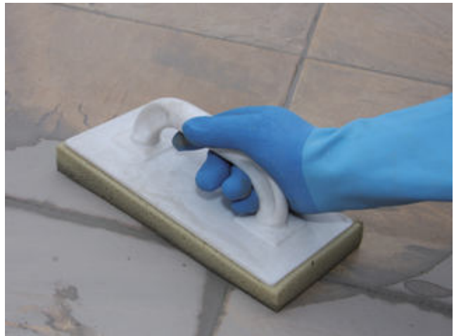
22) Abwaschen des Fliesenbelags nach ausreichender Standzeit der eingefugten Sopro Fugenmasse.
