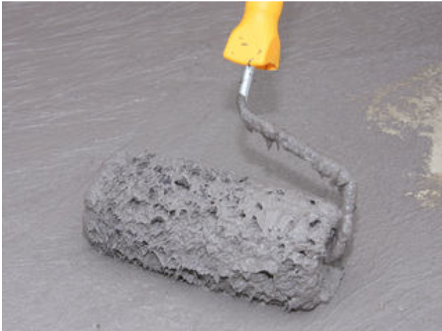
13) Die Verarbeitung der Sopro TurboDichtSchlämme 2-K kann auch mit einer Lammfellrolle erfolgen.
