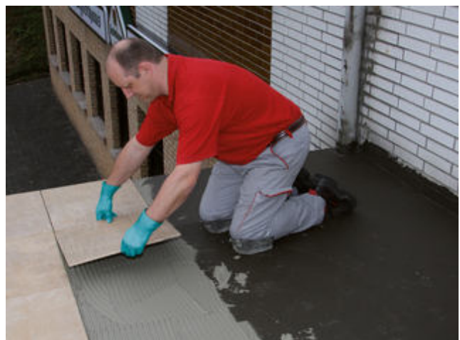
18) Einlegen und Einschieben der Platten in das frische Kleberbett.
