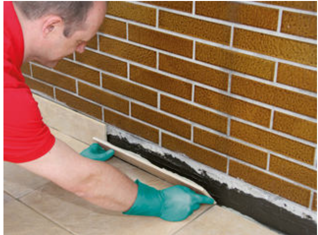
20) ... und Ansetzen der Sockelfliese.
