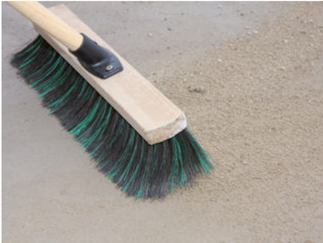
1) Säubern des vorbereiteten, ebenmäßigen Untergrundes.
