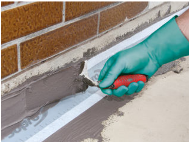
9) Überarbeiten des Sopro Dichtbandes mit Sopro TurboDichtSchlämme 2-K.
