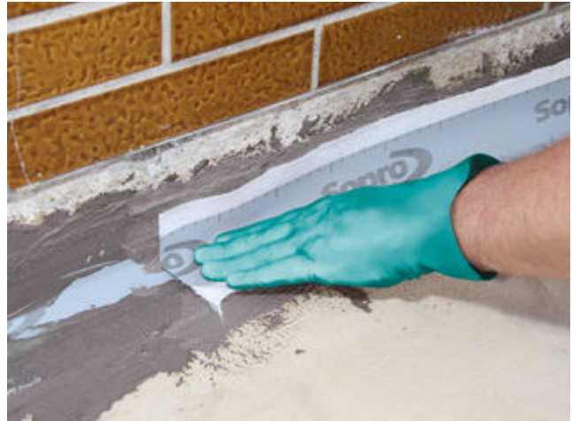
8) ... des anschließend eingelegten Sopro Dichtbandes. Dieses ist zusätzlich einzudrücken.
