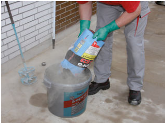
3) Hinzugeben der Trockenkomponente der Sopro TurboDicht- Schlämme 2-K.
