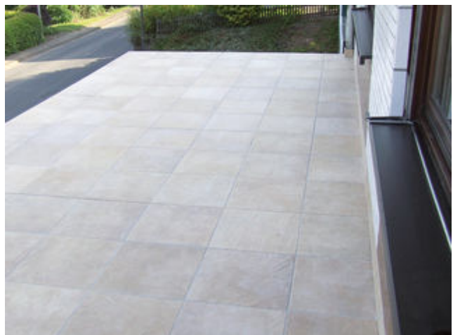
24) Neu verlegter Fliesenbelag auf einem Balkon mit den Sopro Systemkomponenten.
