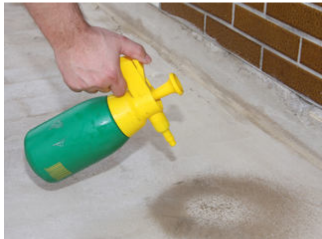
4) Vornässen des Untergrundes im Außenbereich für den nachfolgenden Auftrag der Sopro TurboDichtSchlämme 2-K. Untergründe im Innenbereich sind mit Sopro Grundierung vorzubehandeln.
