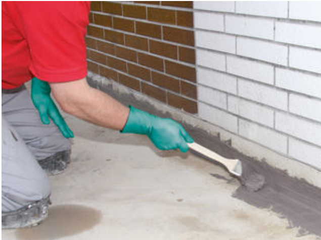
7) Einstreichen des Sockelbereiches mit Sopro TurboDichtSchlämme 2-K zur Fixierung ...
