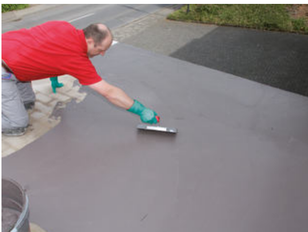
11) Glätten der Sopro TurboDichtSchlämme 2-K mittels Glättkelle.
