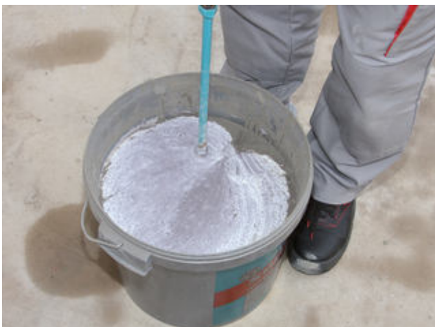
5) Homogenes Anmischen der zwei Komponenten ...
