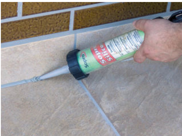
23) Einbringen des Sopro SanitärSilikons in die Anschluss- und Bewegungsfugen.
