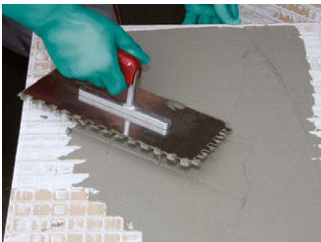
17) Die Anwendung des Buttering-Floating Verfahrens ist von Format und Rückseitenbeschaffenheit der Fliese abhängig und dient der weitgehend vollflächigen Verklebung des Belages.
