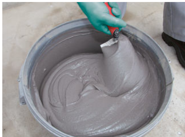
6) ... bis eine verarbeitungsgerechte, cremige Konsistenz erreicht ist.
