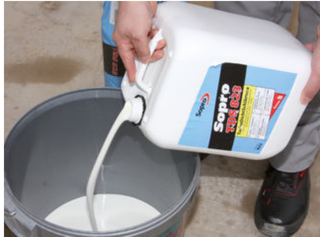
2) Vorgeben der Nasskomponente der Sopro TurboDichtSchlämme 2-K in einen sauberen Eimer.
