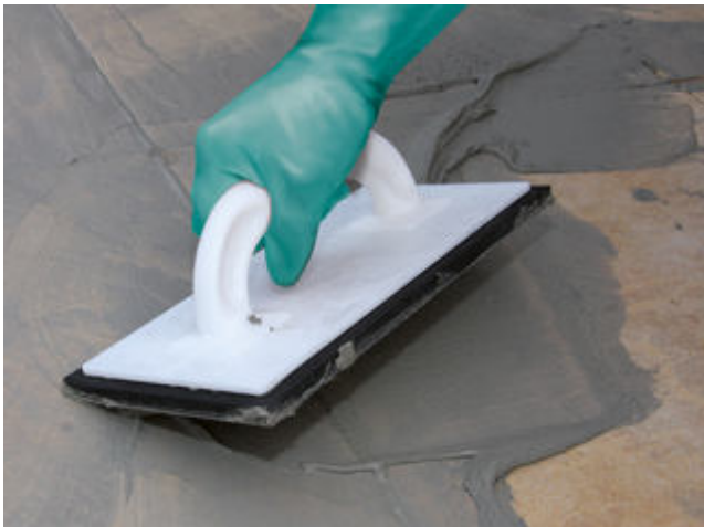
21) Einfügen einer Sopro Fugenmassen (z. B. Sopro DF 10® Design- Fuge Flex oder Sopro FlexFuge FL) nach Erhärtung des Sopro Flexklebers
