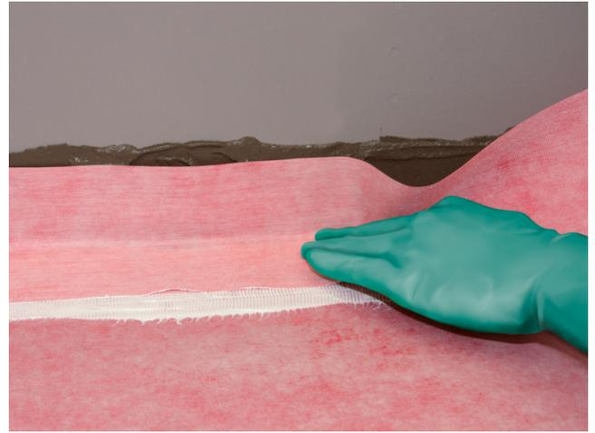
Ein im System geprüftes AEB® Dichtband in das offene Kleberbett einlegen.
