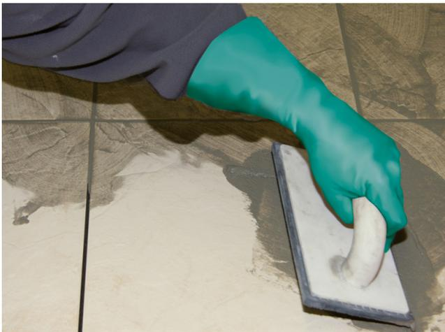
... und nach Erreichen der Begeh- und Verfugbarkeit des Verlegemörtels mit z. B. Sopro DF 10®, Sopro FlexFuge plus oder Sopro FlexFuge FL verfugt werden.
