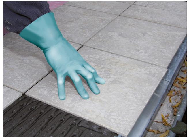
Keramische Fliesen können anschließend ohne lange Wartezeiten im Bodenbereich mit Sopro megaFlex S2 turbo direkt auf Sopro AEB® plus verlegt...
