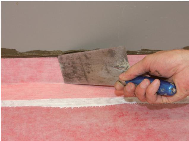
... und mit einer Kelle oder einem Malerrollen-Bügel andrücken. Überschüssigen Kleber auf der Wand entfernen oder zur Wand hin abspachteln.
