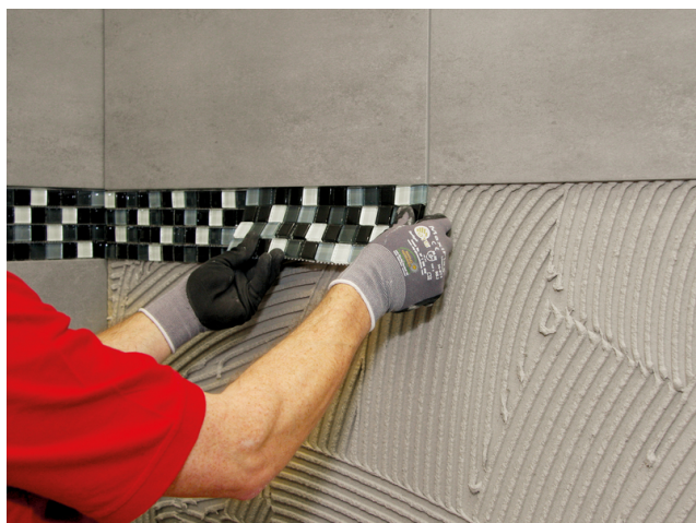
Einlegen von Glasmosaik in das vorbereitete Kleberbett.
