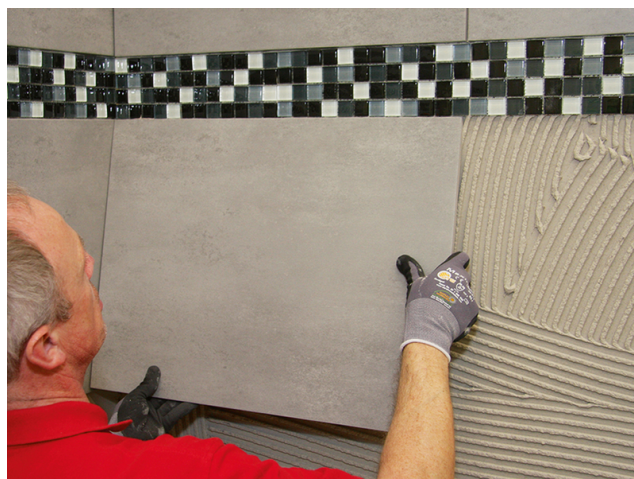
Sehr gute Standfestigkeit zum Ansetzen von großformatigem Feinsteinzeug.
