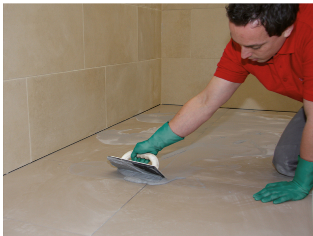
Verfugung der Fläche mit einer Sopro Fugenmasse (z.B. Sopro DF 10 DesignFuge Flex, Sopro Brillant Perlfrage)
