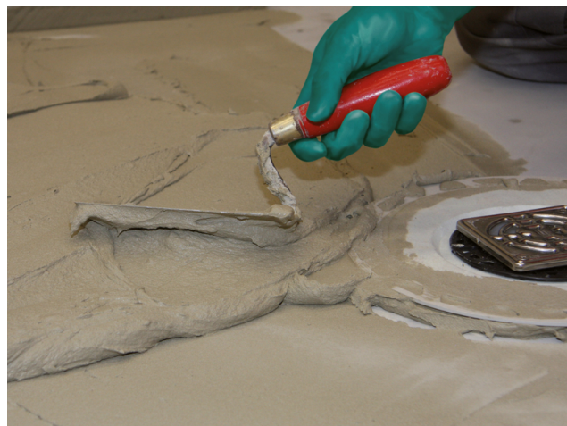
Danach Sopro FKM XL in Spachtelkonsistenz auf den Untergrund aufbringen...
