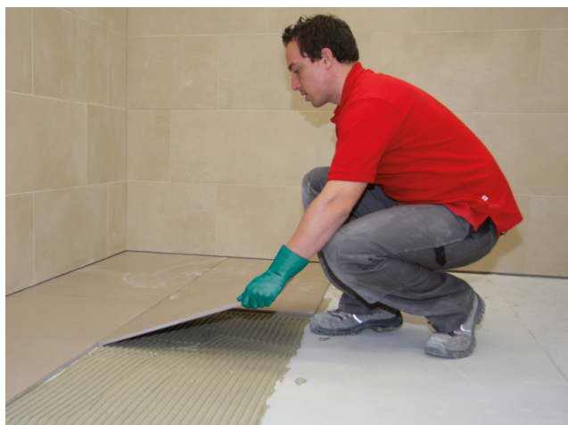
Großformatiges Feinsteinzeug einlegen und ausrichten. Fugennetz
