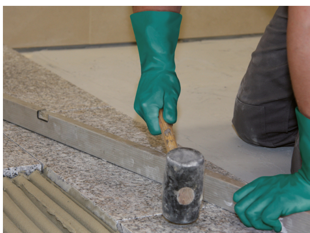
Einklopfen der Natursteinplatte und Überprüfung auf Ebenmäßigkeit.
