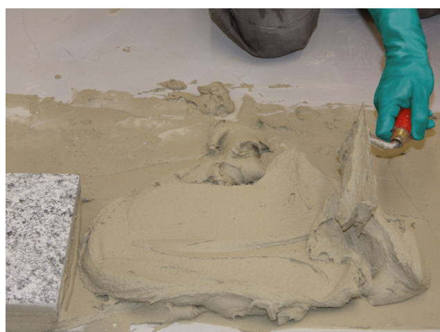
Sopro FKMXL ist für höhere Mörtelschichtstärken bis 10 mm auch mit der Kelle Verarbeitbar.
