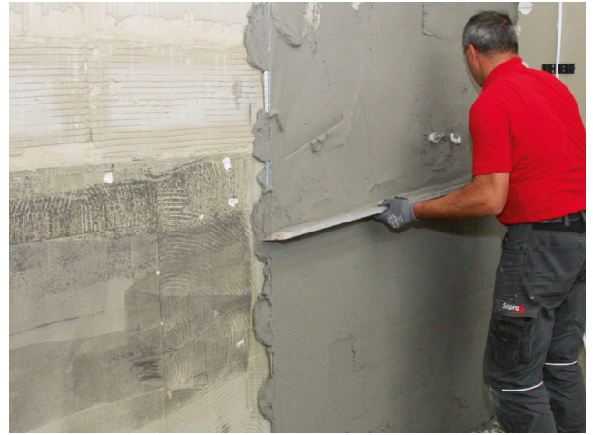
Anschließend den Putz mit einer Latte über die Putzschienen sauber von unten nach oben abziehen.
