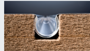
Omega-Form der Rohrkanäle
